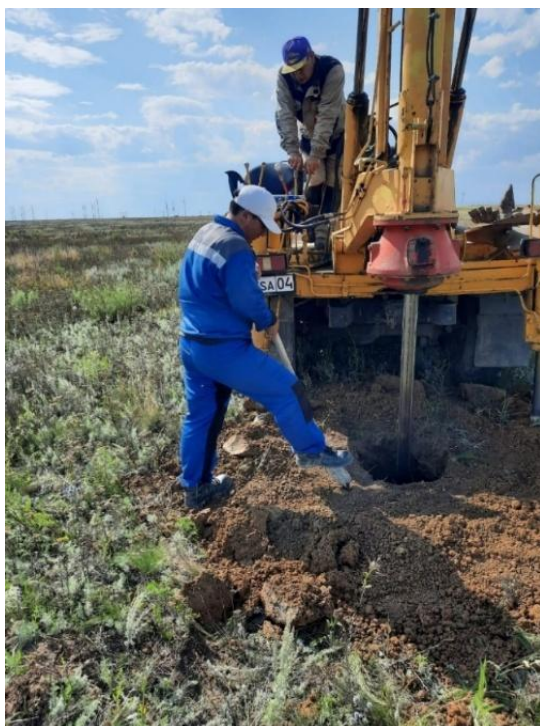
Рисунок 7 - Изготовление лунки репера
