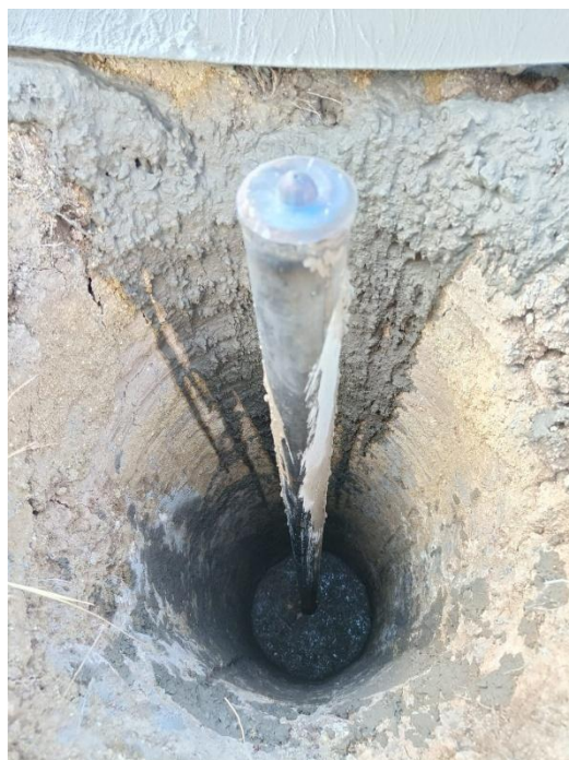
Рисунок 8 - Установка пункта и заливка якоря
